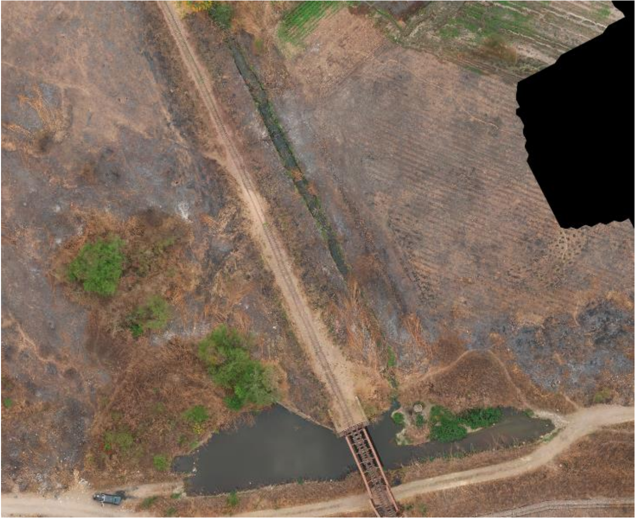
Acumulación de aguas servidas. Cabecera norte puente ferrocarril sobre Río Los Alisos. Dron 25/09/2024.
