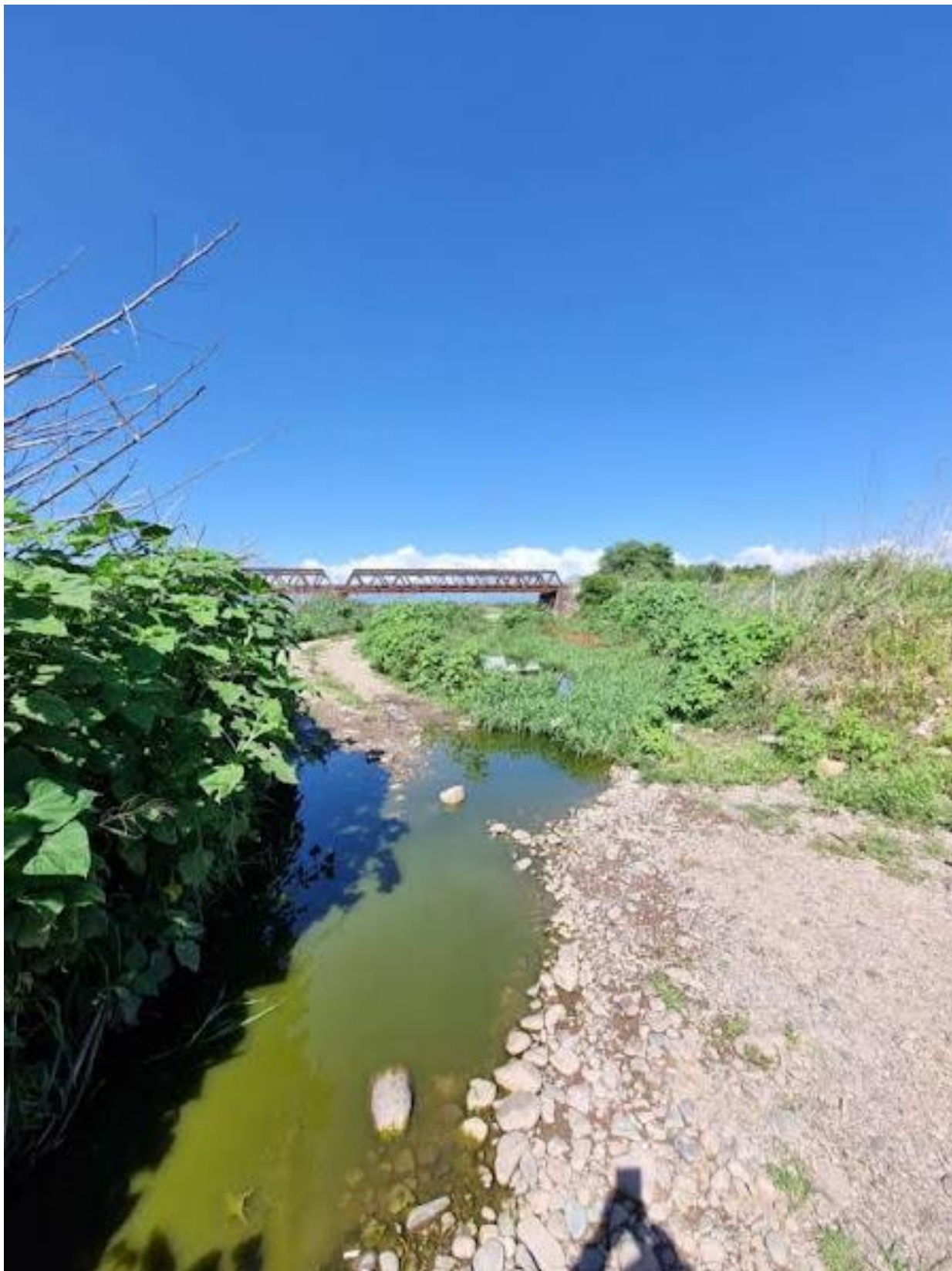
Puente ferrocarril sobre río Los Alisos. Cruce camino. Agua servida cruza el camino yendo a desaguar al río. Foto 27/12/2024.
